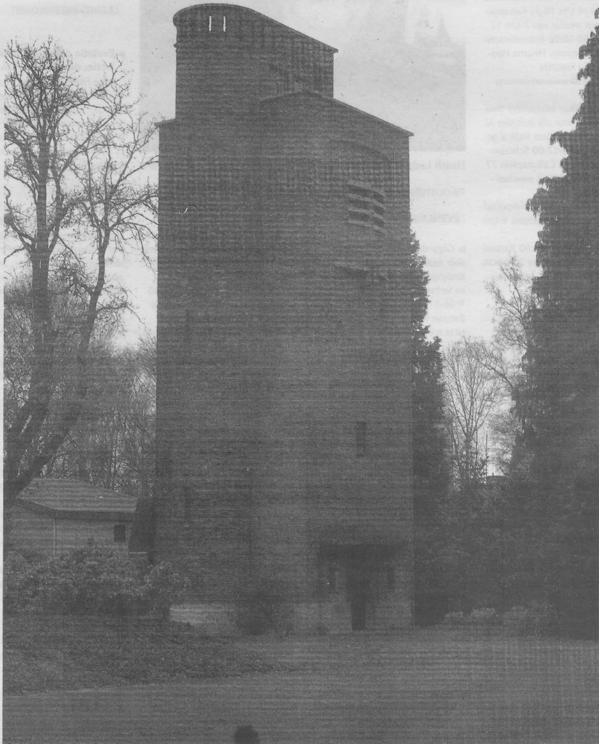
De eigenaar van de uit 1938 daterende watertoren in Doorwerth wil het gebouw opnemen in een op te richten woon/werkplek.
